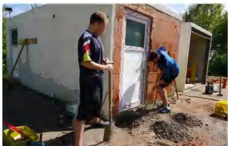
2017 Ausbau der gespendeten Garagen zu neuen Toilettenanlagen
