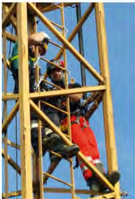
Hoch hinaus am Kran
