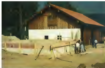
Aufbau der Schalung für die Fundamente
