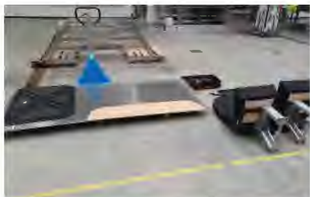
Sorgfältiger Zuschnitt der neuen Blechverkleidungen
