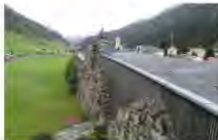
Die Lawinenstützmauer des Alpinariums in Galtür
