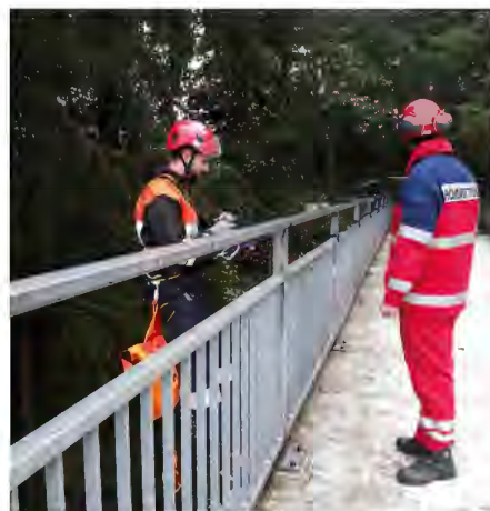
Sicherung am Geländer
