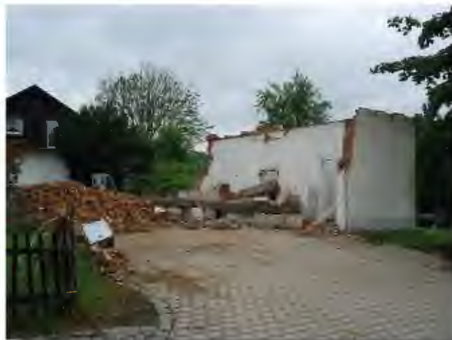
... musste 2013 der neuen Nahwärmeversorgung weichen.
