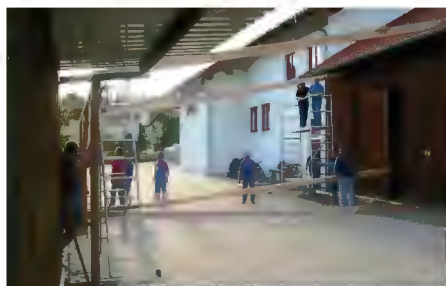
2004 Zeltdachaufbau vorm Bauhof
