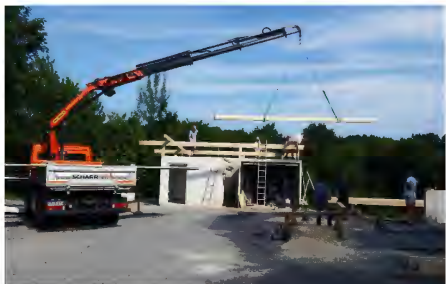
2018 Bedachung der Toiletten ...
