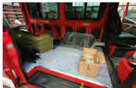
Sitze, Boden und Seitenplatten wurden komplett entfernt.
