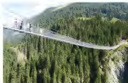
Die Hängebrücke bei Holzgau im Lechtal 200m lang, 110m hoch, 1,2m breit
