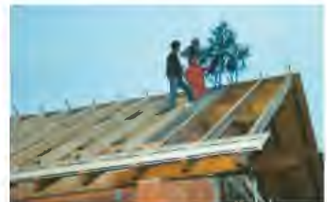
Richtfest mit Zimmerermeister Grotz
