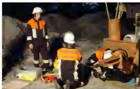
2005 Einsatzübung THL mit Verwendung der Hebekissen
